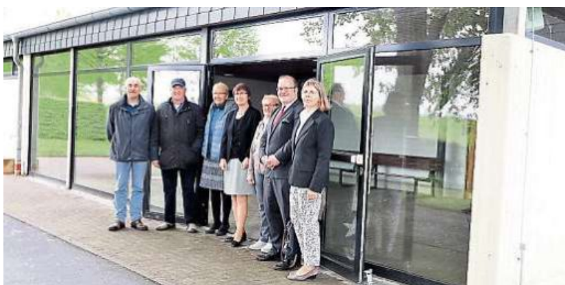
Endlich winddicht: der Vorraum der Allendorfer Friedhofskapelle mit der schmutzigen Glasfassade wurde jetzt offiziell vorgestellt. Foto: Schäfer
