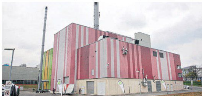
Auf Grün-Gelb folgt Rot-Weiß: Vorne das neue Heizkraftwerk der SWG, dahinter die vor neun Jahren errichtete TREA I.
