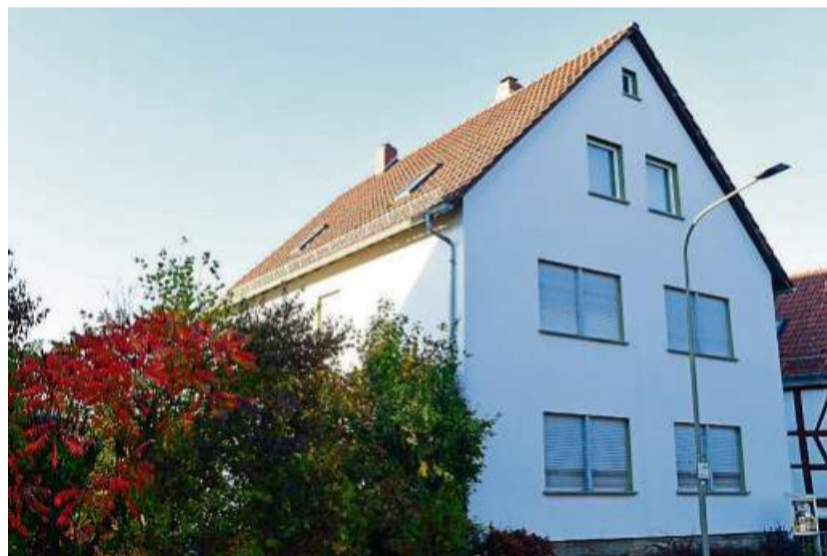
Ins Pfarrhaus zieht nach Renovierungen das Kinderland ein.
